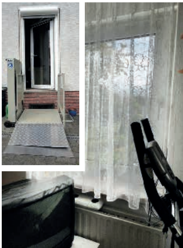
Die beiden Bilder zeigen den Umbau eines ehemaligen Fensters zu einem Zugang, der nun von außen mit Hilfe eines Rollstuhl-lifts barrierefrei genutzt werden kann. (Quelle: Werra-Meißner-Kreis, Fachdienst Sozialplanung.)
