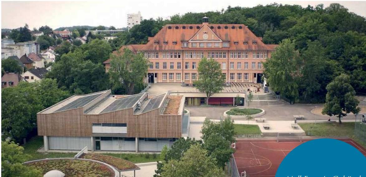
Der neue Fachklassentrakt vor dem alten Hauptgebäude
