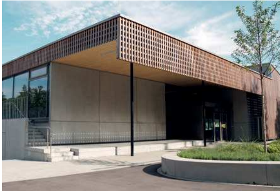
Die hohen Anforderungen an den neuen Fachklassentrakt...
