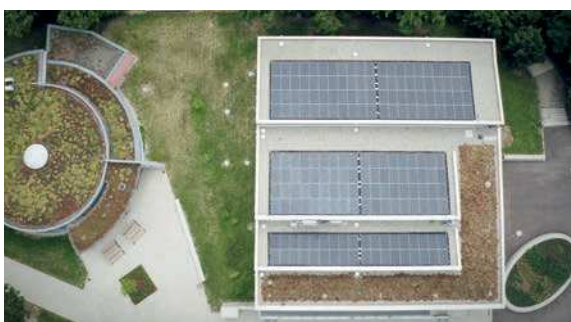
Die PV-Module liefern den benötigten Strom
