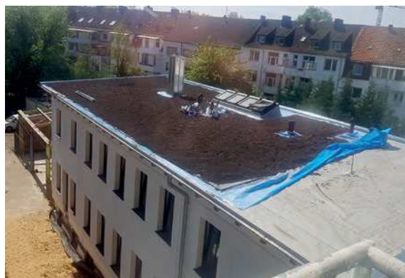
Im Neubau wird das Gründach künftig mitgeplant
