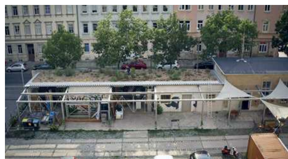
Pilotprojekt: So funktioniert Dachbegrünung
