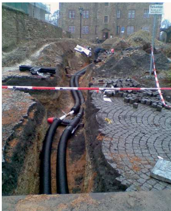
...bis zum Bau des neuen Nahwärmenetzes
