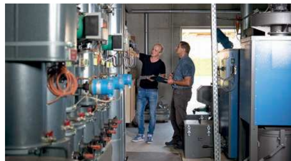
Kontrolle der Heizanlage
